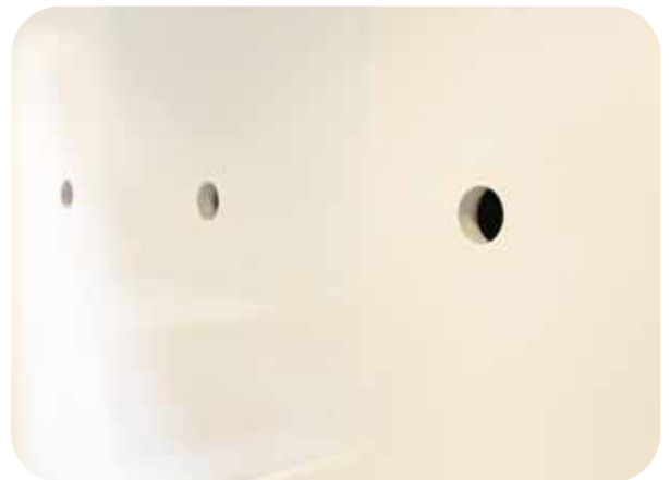
Die Luft strömt aus 30 Düsen, Durchmesser 38 mm, mit einer Geschwindigkeit von über 100 km/h.
